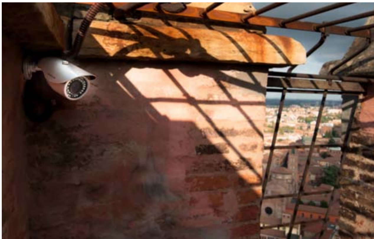
FIG. 8 – BOLOGNA, TORRE DEGLI ASINELLI. La protezione della Torre degli Asinelli di Bologna è uno dei progetti sostenuti dalla Fondazione Enzo Hruby. © EHF.
