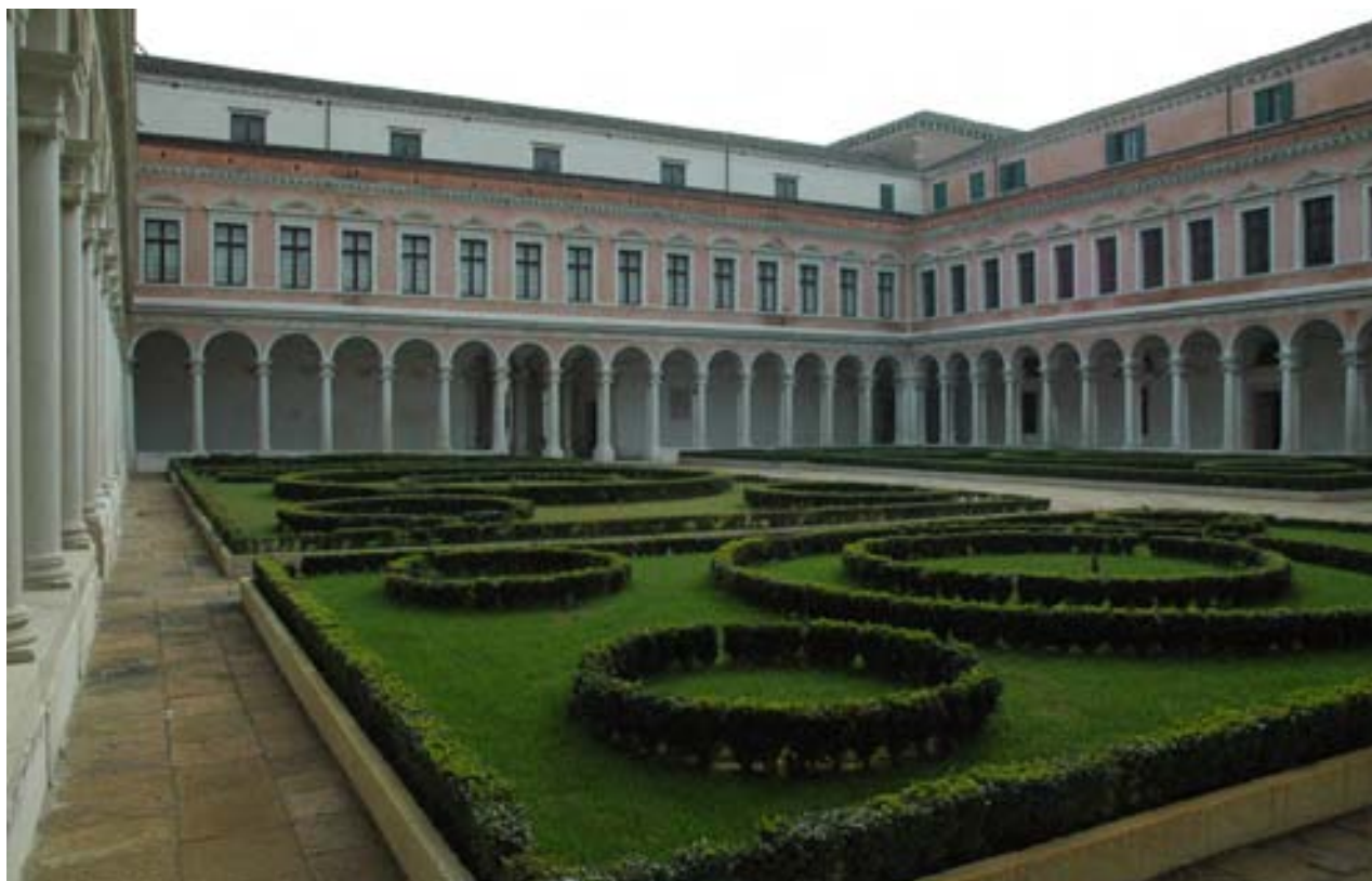
FIG. 7 – VENEZIA, ISOLA SAN GIORGIO MAGGIORE. La Fondazione Enzo Hruby ha sostenuto la messa in sicurezza dell'Isola di San Giorgio Maggiore a Venezia, sede della Fondazione Cini. © EHF.
