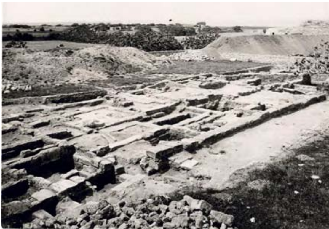
FIG. 14 – EGNAZIA – FASANO (BR), Vecchi Scavi. © SBAP.
