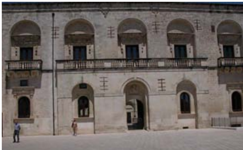
FIG. 7 – MURO LECCESE (LE) - PALAZZO DEL PRINCIPE, MUSEO CIVICO DI BORGO TERRA, ingresso. © MCBT.
