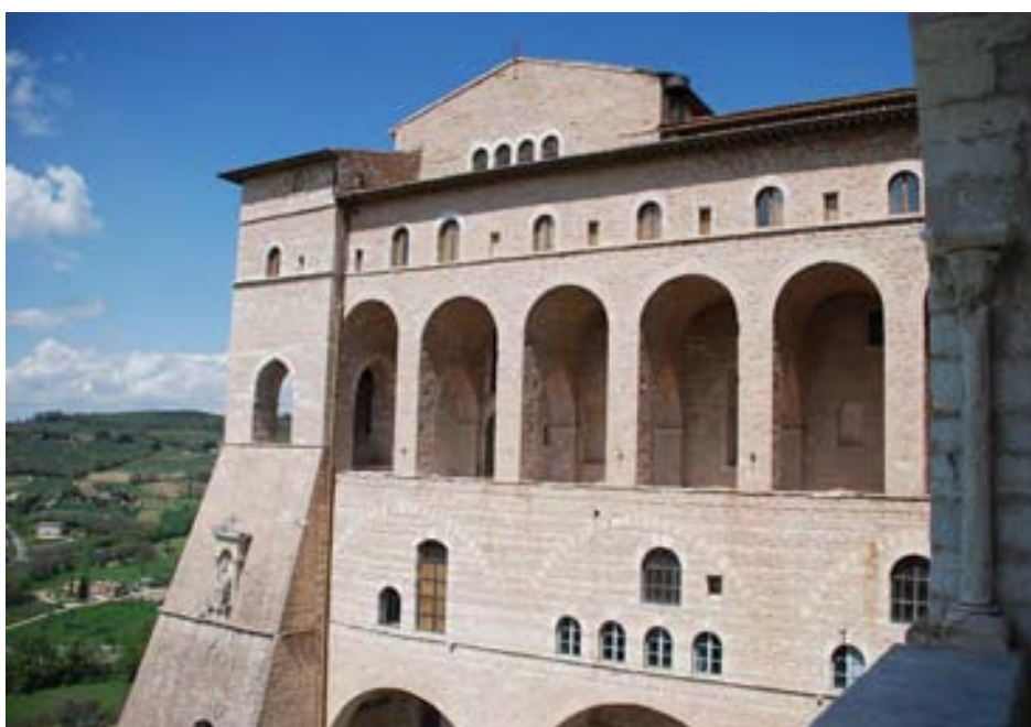
FIG. 6 – ASSISI, SACRO CONVENTO. Il primo progetto sostenuto dalla Fondazione Enzo Hruby è stato la protezione della Biblioteca del Sacro Convento ad Assisi. © EHF.
