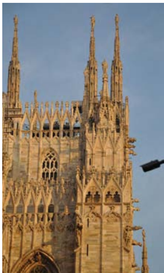
FIG. 2 – MILANO. Il progetto di videosorveglianza del Duomo di Milano, sostenuto dalla Fondazione Enzo Hruby in collaborazione con Samsung Techwin, unisce la tutela di un bene culturale unico al mondo e simbolo stesso di Milano con il controllo urbano di un'area estesa la cui protezione giova alla tranquillità dei cittadini e dei turisti. © EHF.
